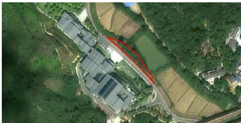
图 4 国有建设用地使用权地块 05 现状影像图
